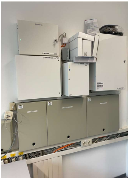
Abbildung 13: Einbruchmeldeanlage im Bestand
